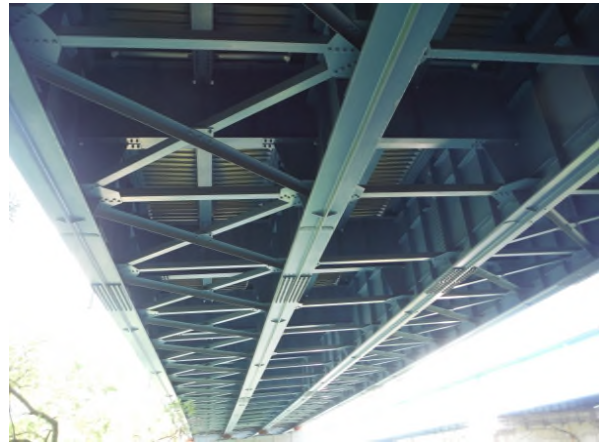
거더 및 브레이싱 전경
