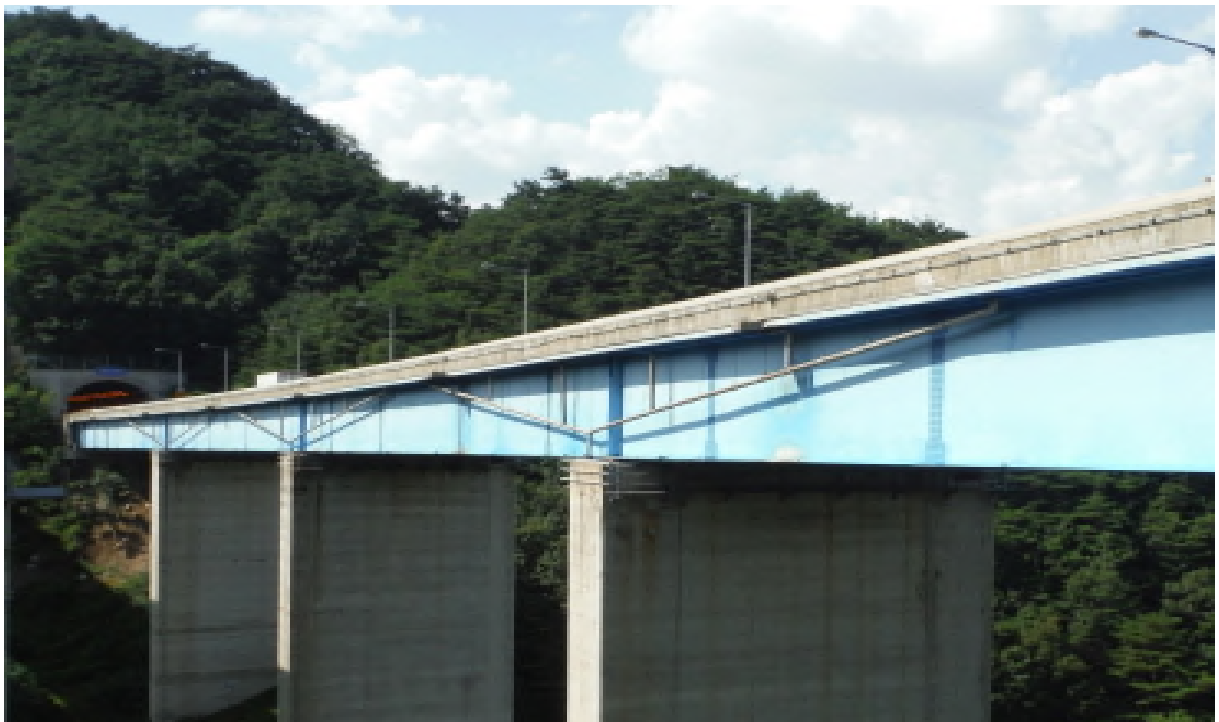
백운4교(춘천) 측면 전경
