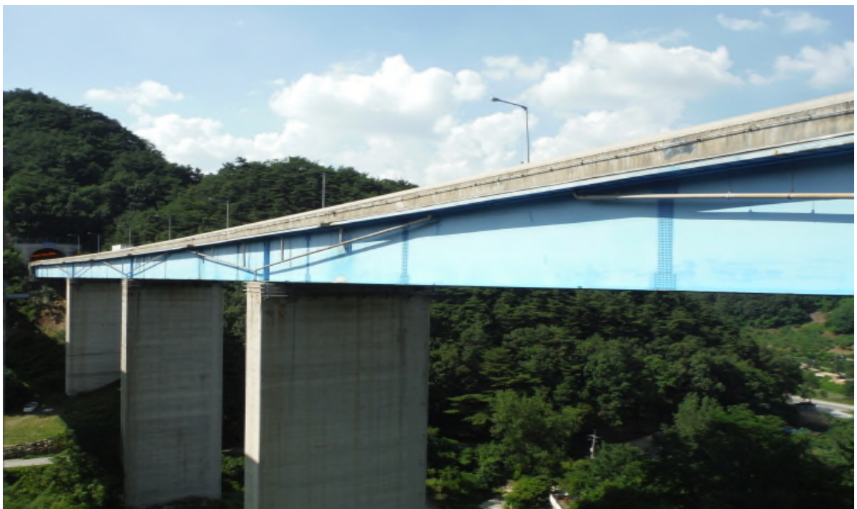
백운4교(부산) 측면 전경
