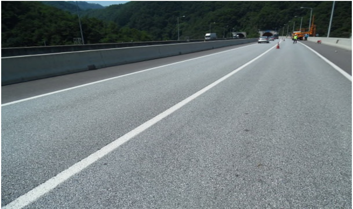
백운4교(춘천) 상면 전경
